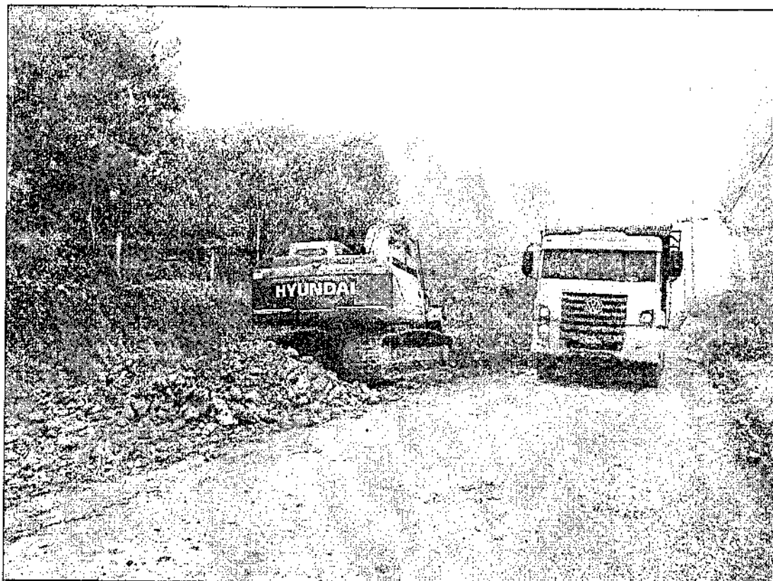
Foto nº. 03- Escavação para alargamento próximo da estaca 152.
