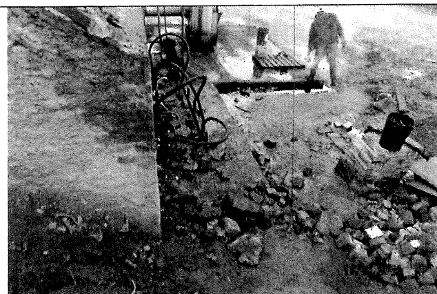
Foto 4 – Contaminação fora da contenção do queimador
