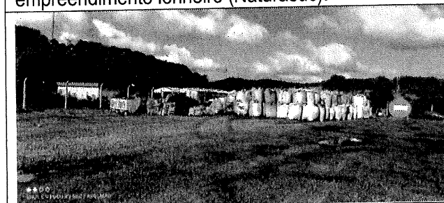
Foto 21 – Cinzas e escoria armazenado no empreendimento.
