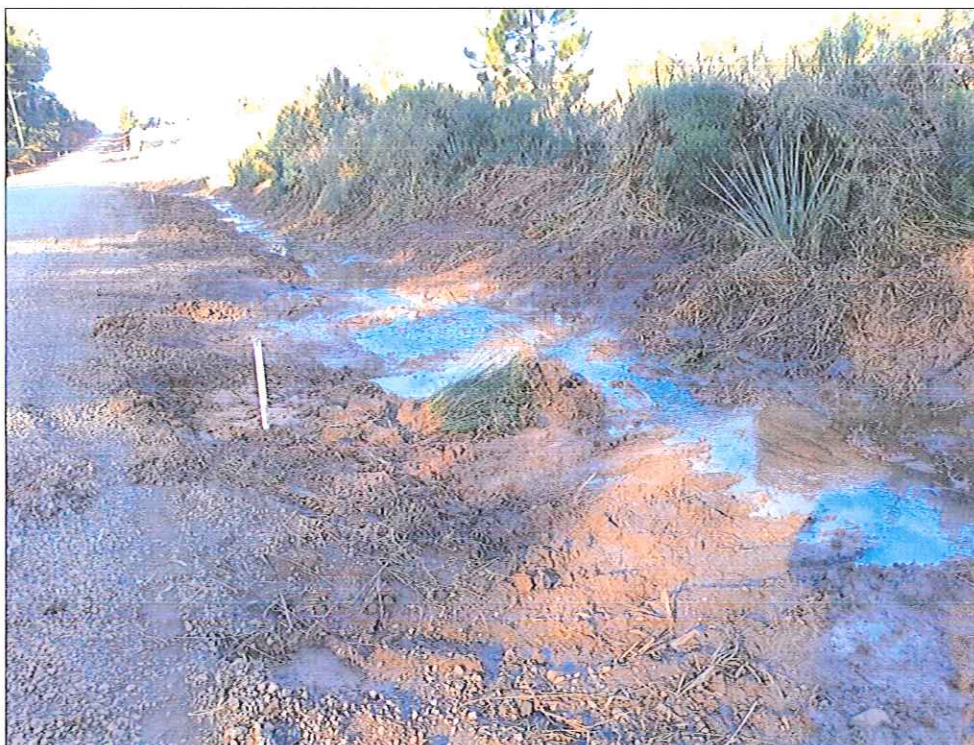
Foto nº. 07- Ocorrência de solo mole e água próximo da estaca 172.
