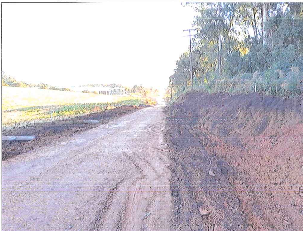
Foto nº. 02- Escavação para alargamento próximo da estaca 184.
