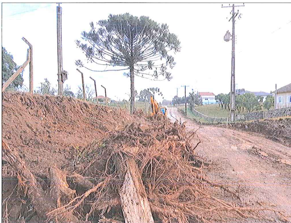
Foto nº. 04- Escavação para alargamento próximo da estaca 135.
