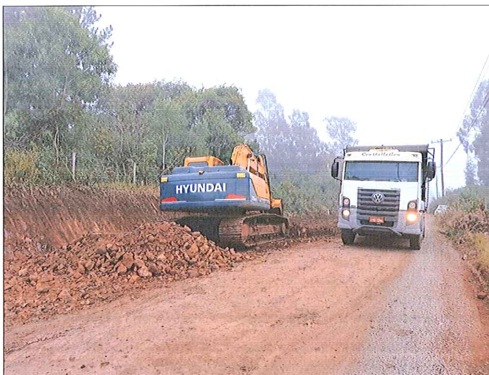
Foto nº. 03- Escavação para alargamento próximo da estaca 152.
